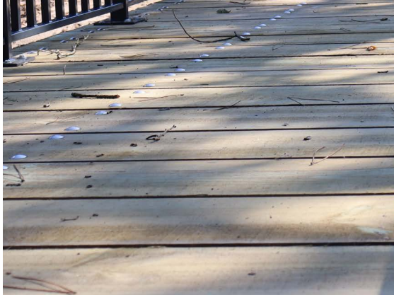
La passerelle de la piste Lo Camin de Hè
