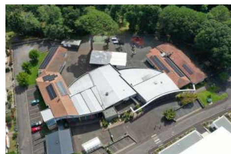
Exemple d'installation de panneaux solaires
